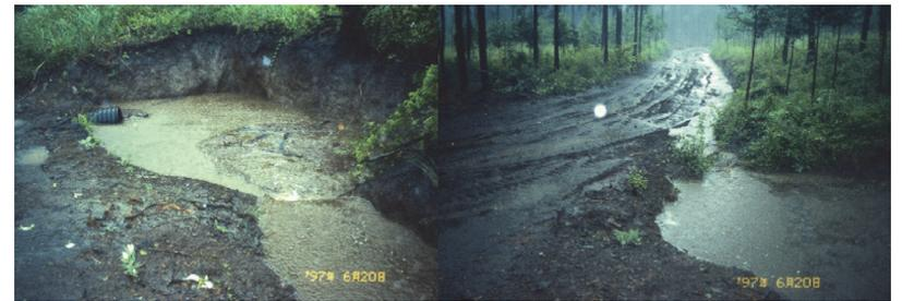
写真 1 時間雨量 70 mm 時の防災水源涵養路（右）と浸透升（左）（富士山大沢では過去 30 年間で最大の土石流が発生）
