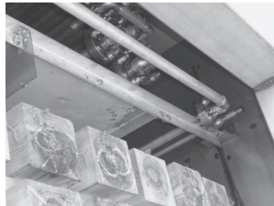
図 2 改修の一例 (中天井と積み間バッフル板)
