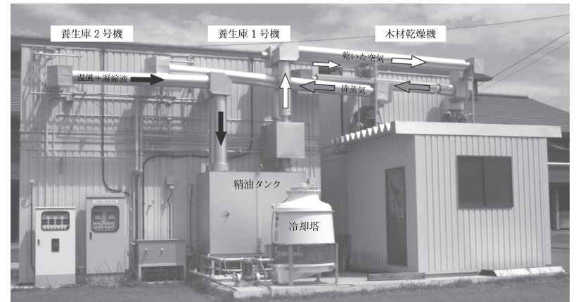
図1 乾燥システムの概要
