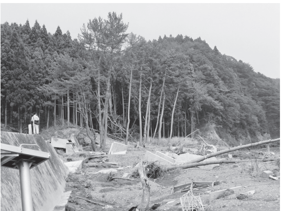
写真 2 損壊した防潮堤。防潮林が流失した跡の向こう岸には、流失を免れ生き残った防潮林のマツが見える。(岩手県大船渡市赤崎町合足海岸 (防潮堤と県有防潮林))
