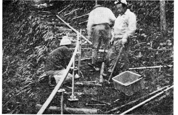
写真1 レール支柱建設作業 東吉野村中黒地内
